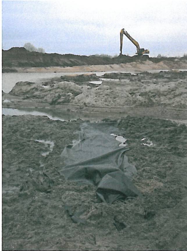
Afbeelding 7) Na verkenning is het scheepswrak afgekt met worteldoek.
