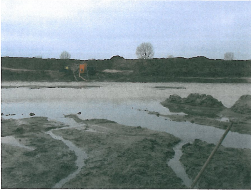
Afbeelding 3) Één van de pompen vlak onder de dijk.
