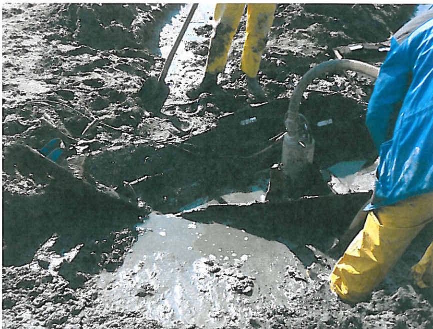
Afbeelding 8) Gevecht tegen het toestromende water.
