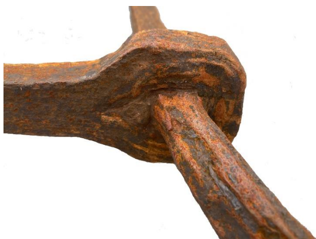
Afbeelding F Verbinding stok en zijarmen muuranker.
