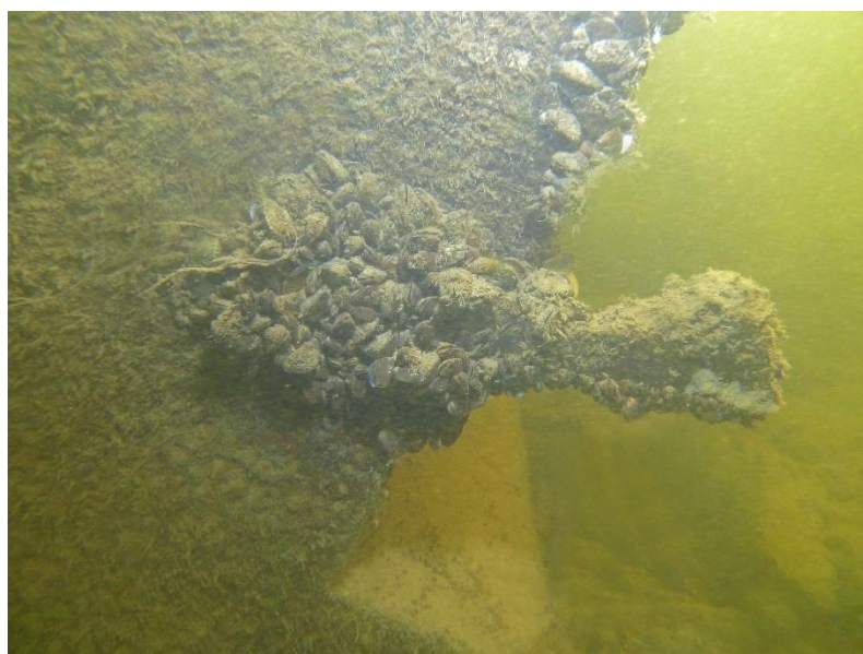
Afbeelding A Zijkant Sluitsteen A met taps-gevormd smeedijzeren anker.
