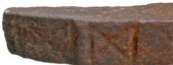
Afbeelding C Uiteinde muuranker met spijkerkoppen. Zijaanzicht.
