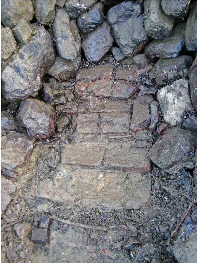
Afbeelding D Bakstenen fundering boven plaat III.
