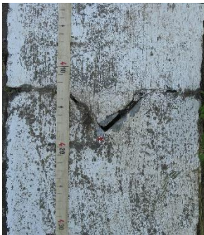
Afbeelding 11 De V-groef verbinding.
