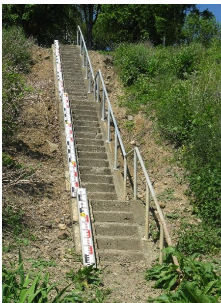
Afbeelding 2 Een moderne hellende peilschaal in het Belgische Lanaken aan de Maas.
