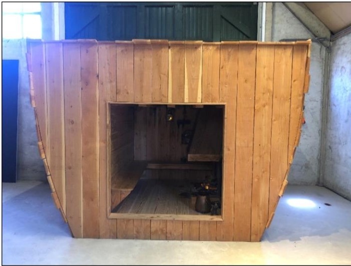
Figuur 29: Reconstructie van een roefje van boottype 'een ventjager' in Batavialand. Bron: Foto van Maaïke Honshorst op 15 juni 2021.
