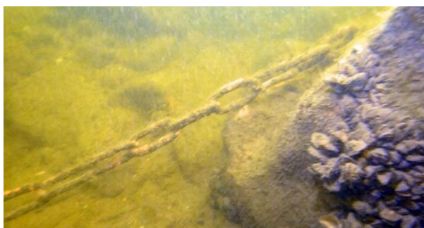
Ankerketting rond het bewerkt natuursteen blok. De ketting slijt in het blok.
