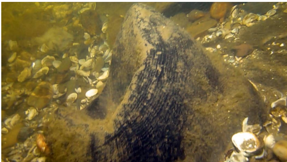
Afbeelding 8 Kop van een funderingspaal.
