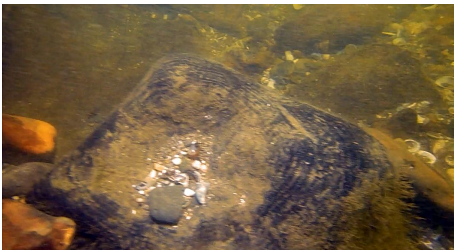
Afbeelding 9 Kop van een funderingspaal.
