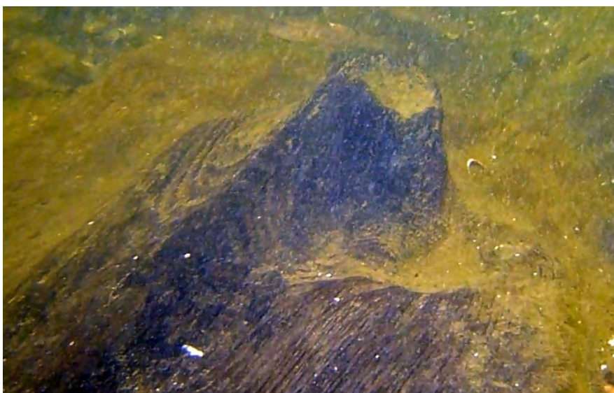
Afbeelding 13 Uitstekende knoest in de centrale balk.
