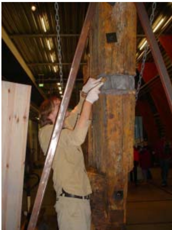
Afbeelding 4.18: Monteren loodbeslag achter het oog van de vingerling, fotonummer Dsc00908.
