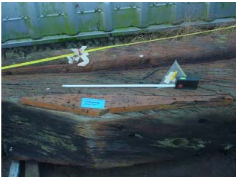
Afbeelding 6.4: Detailfoto van een deel stuurboordzijde van de voorsteven. Een los stuk eikenhout bleek te passen in de voorsteven.
