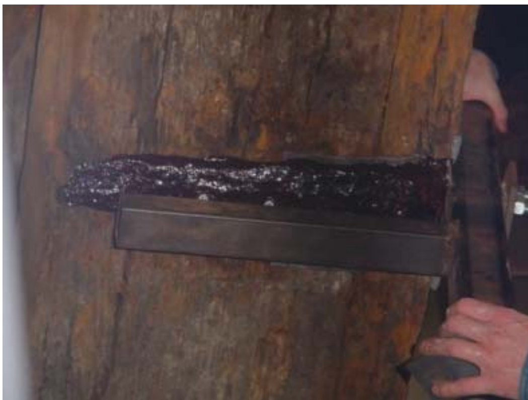
Afbeelding 4.27: Gemonteerde vingerling met nieuw geboorde gaten voor de houtdraadbouten, fotonummer Dsc00932.
