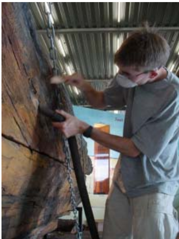
Afbeelding 4.33: Schoonmaken hoofdconstructie met borstels en stofzuiger, fotonummer Dsc00795.
